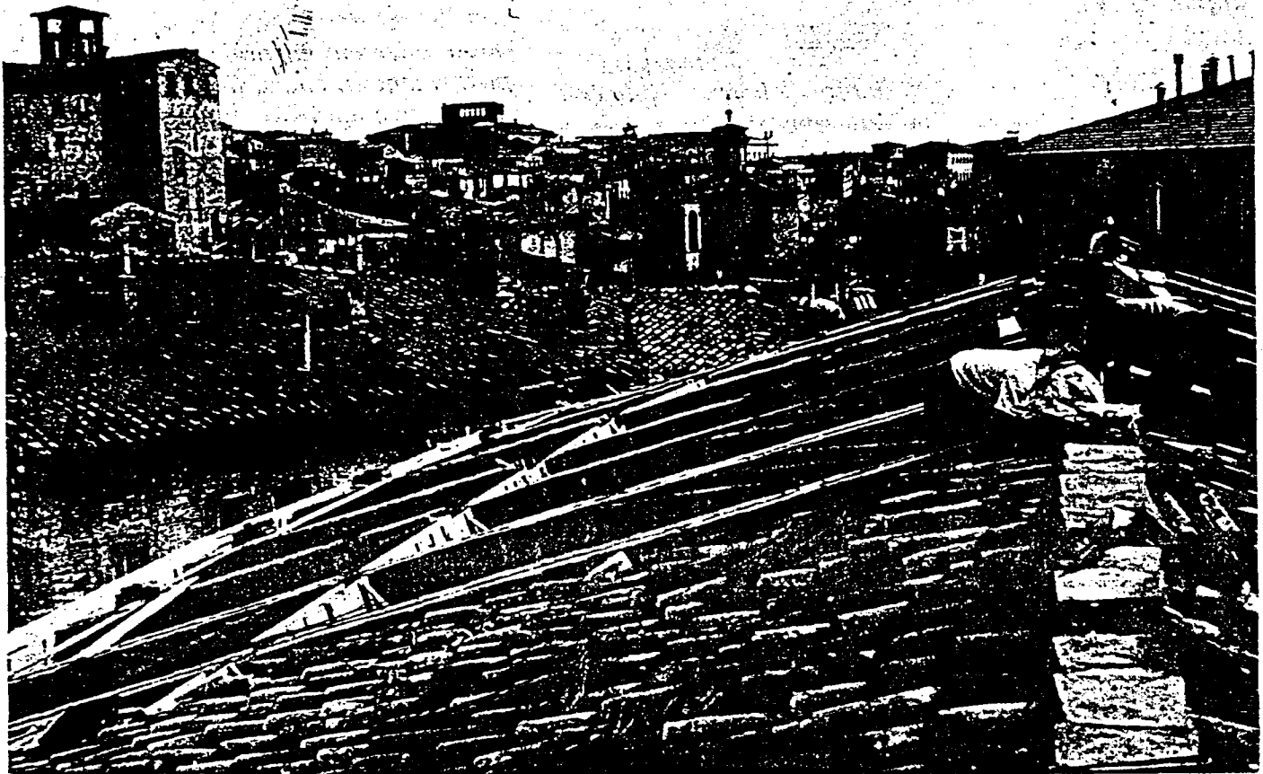
Lavori di copertura del Teatro Comunale Morlacchi nel Centro Storico di Perugia, 1950 Covering of the Morlacchi Municipal Theatre in the Historical Centre of Perugia, 1950 Couverture du Théâtre Communal Morlacchi dans le Centre Historique de Pérouse, 1950
