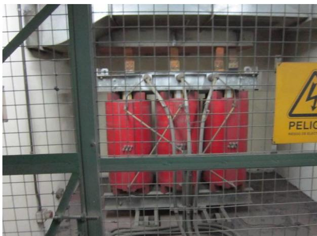
Las salidas en BT de los transformadores terminan en los correspondientes tableros generales de BT.
