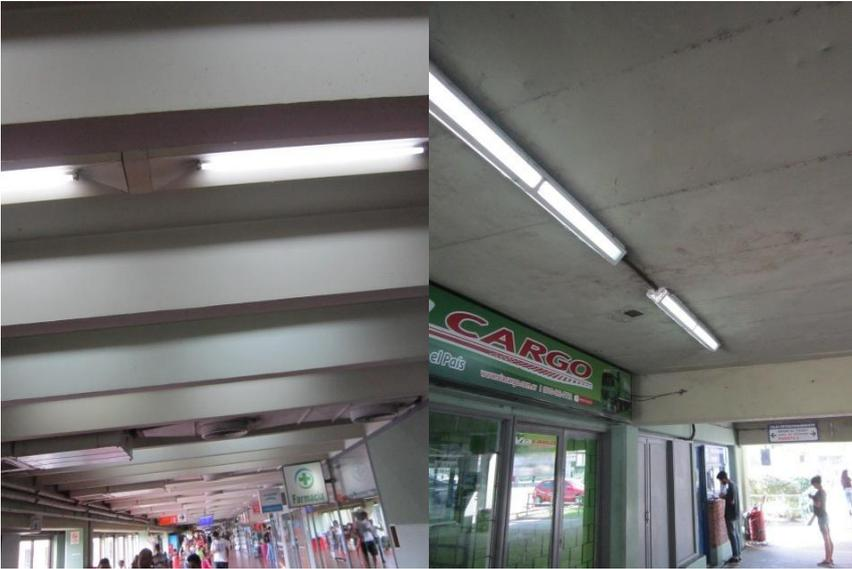
En sectores semi cubiertos como son las plataformas de embarque existen artefactos embutidos a gran altura con lámparas de mercurio de alta presión y bajo consumo con distinta reproducción de color y niveles de iluminación.
