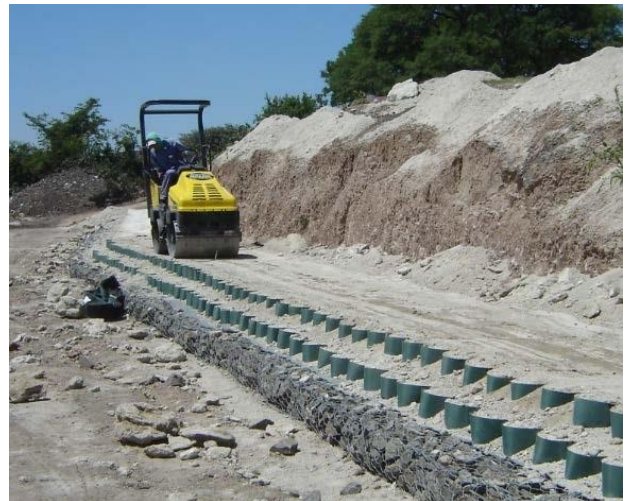
Figura 5.18 Ejecución del recubrimiento con geoceldas
