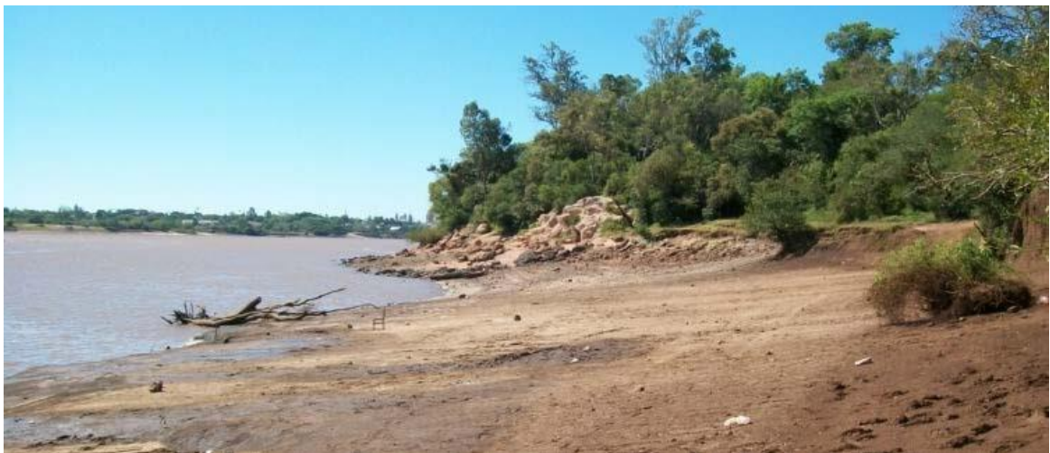
Figura 5.8 Vista del inicio de la barranca de suelo cohesivo en progresiva 400 m.
