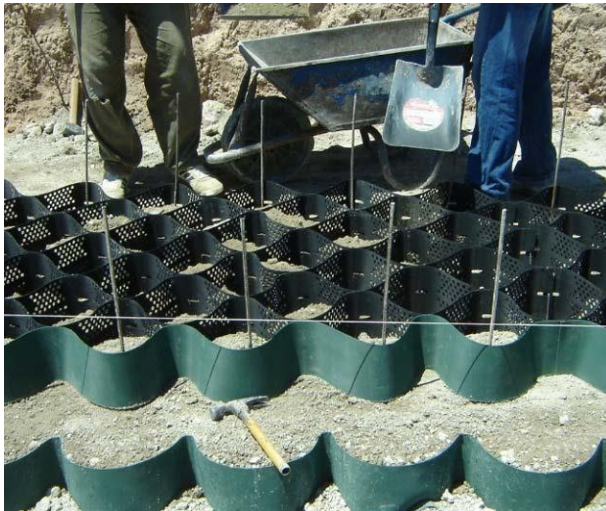
Figura 5.18 Ejecución del recubrimiento con geoceldas
