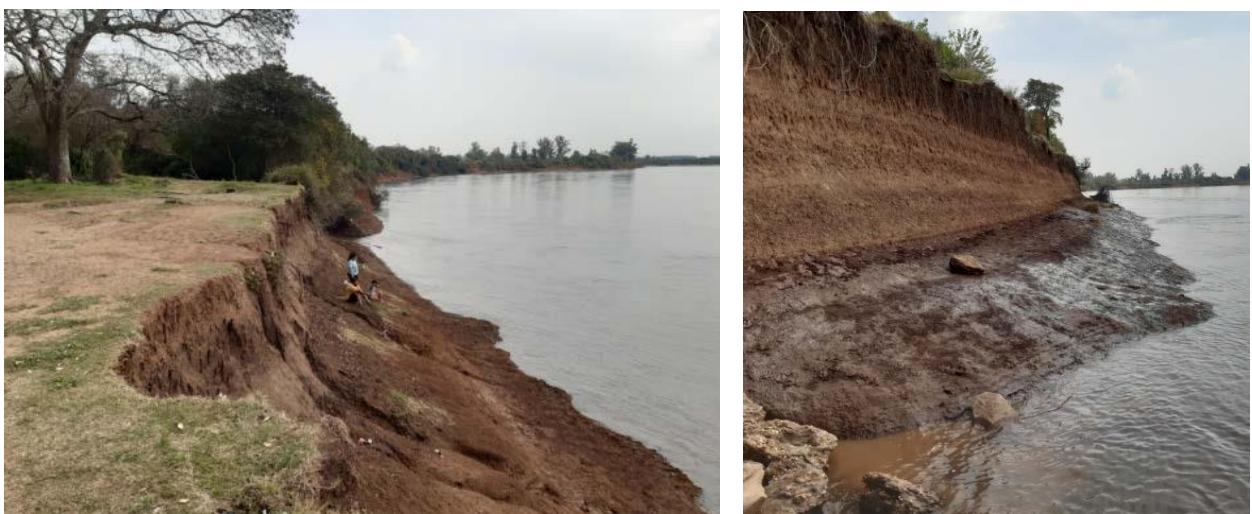
Figura 5.7 Vista del frente de la barranca de suelo cohesivo.
