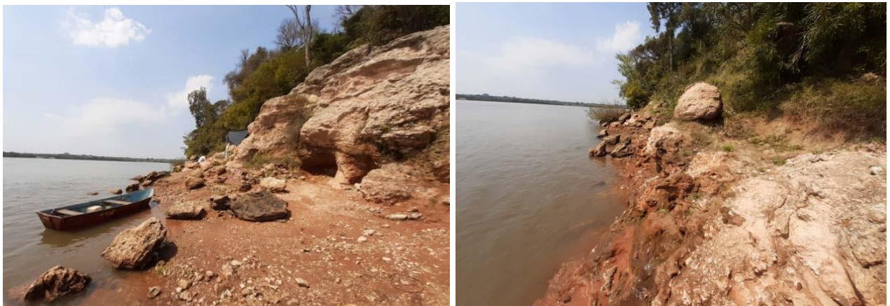
Figura 5.3 Vista de la zona aguas arriba de la Toma de Agua con tosca calcárea aflorante.
