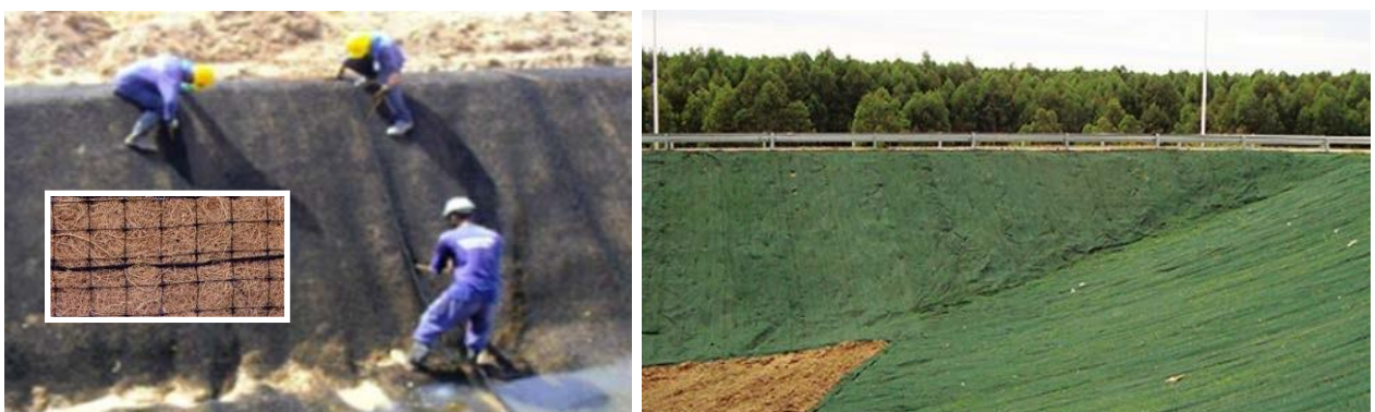
Figura 5.12 Protección de taludes con geomanta y siembra de césped
