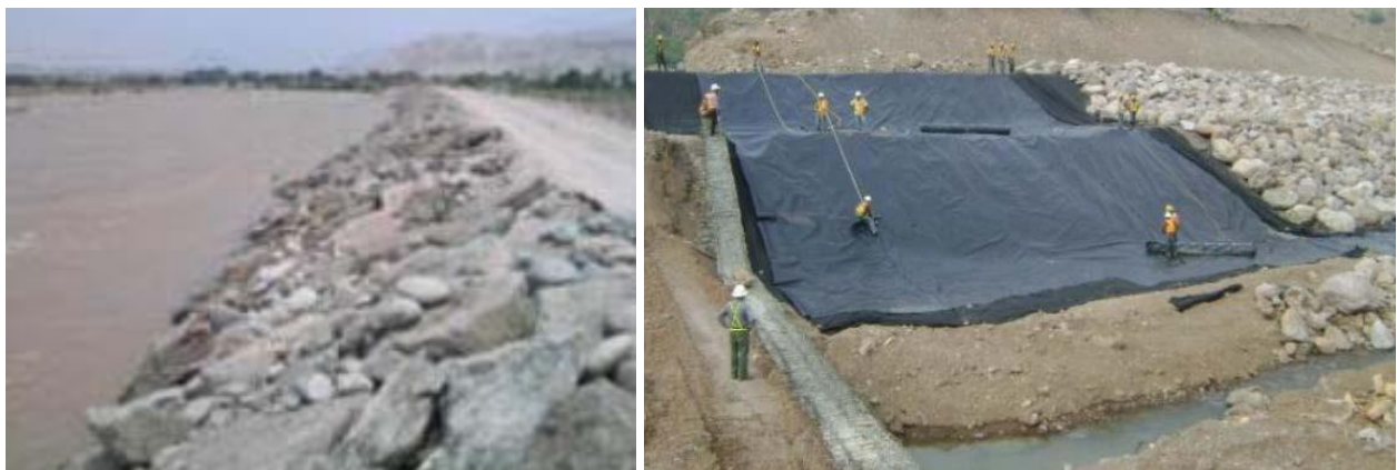
Figura 5.14 Alternativa de protección con enrocado
