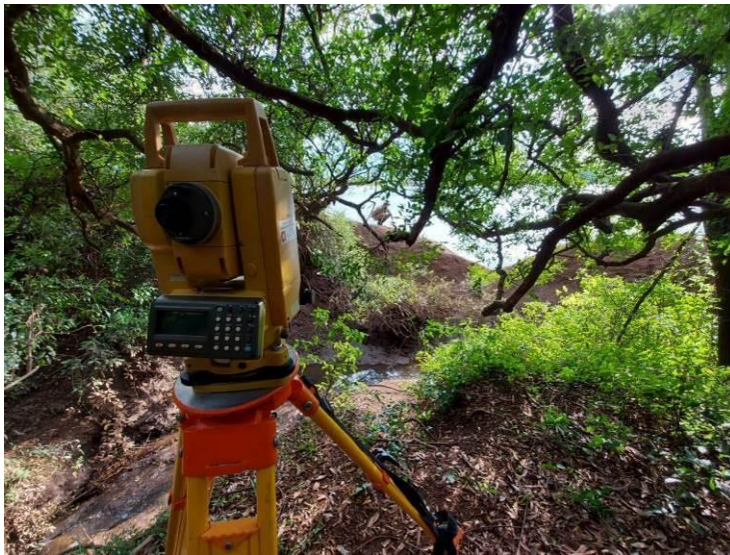
Figura 2.2 Medición con Estación Total
