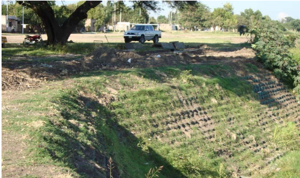
Figura 5.19 Recubrimiento con geoceldas vegetado
