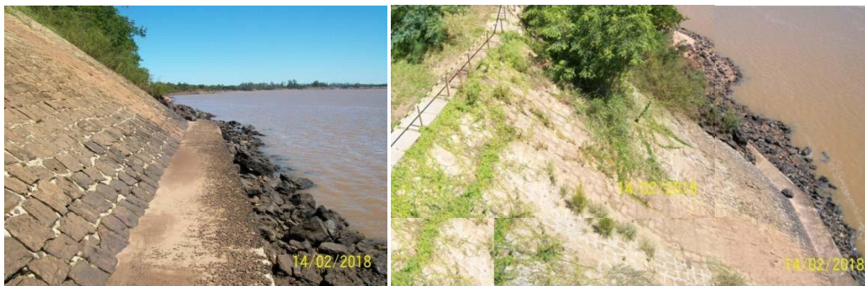
Figura 5.1 Vista de la protección aguas arriba de la Toma de Agua
