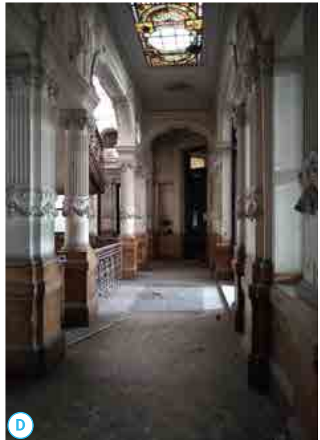
Hall y circulación
