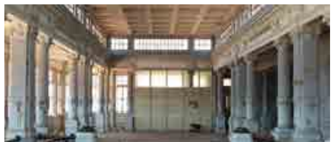
Eliminación de la claraboya y su reemplazo por una losa casetonada de hormigón.
